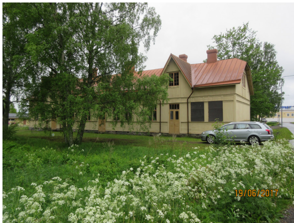
Kuva 8. Kohde 2 kuvattuna vuonna 2017. © Ramboll
